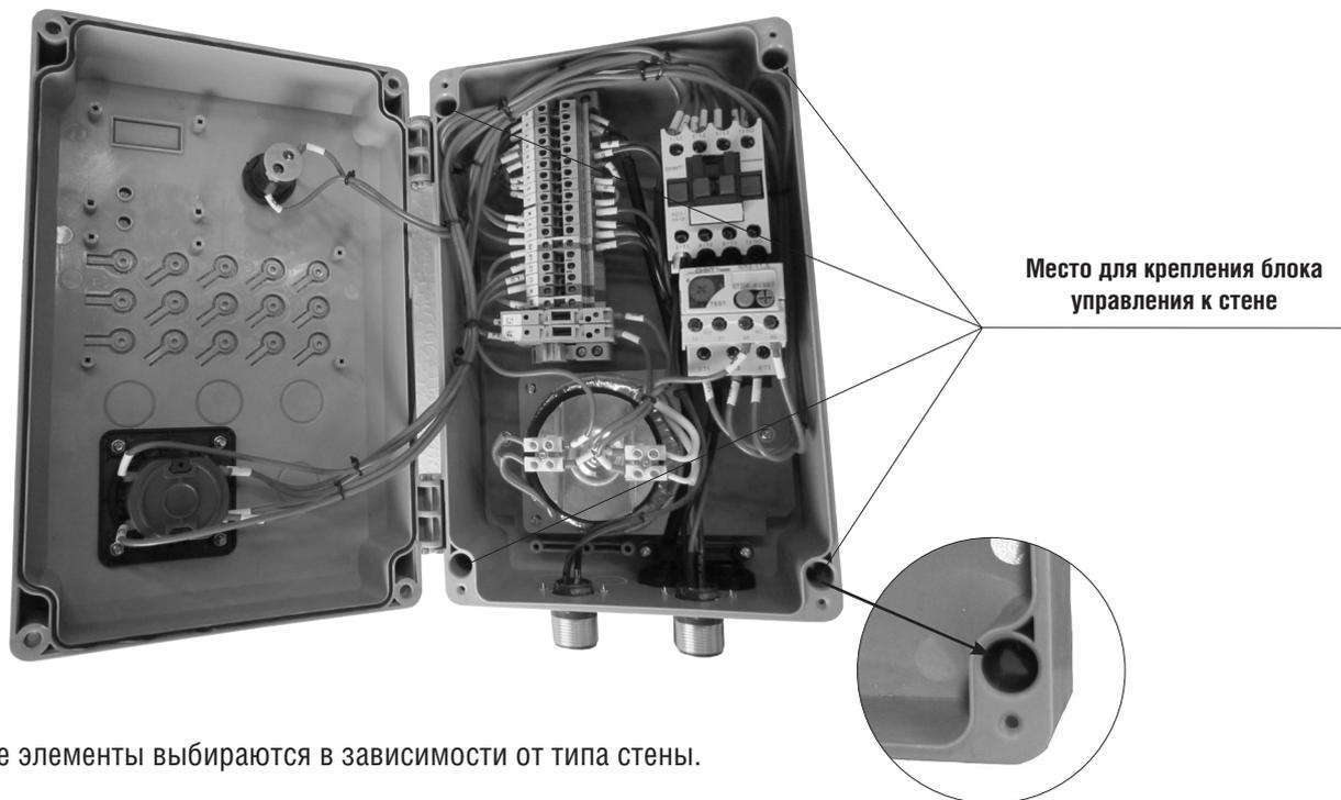
Крепежные элементы выбираются в зависимости от типа стены.
